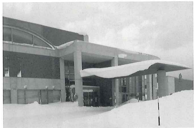
羽幌町総合体育館
