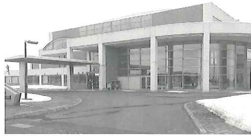
羽幌町総合体育館
