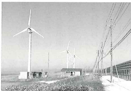
国道沿いに建設された小形風車
