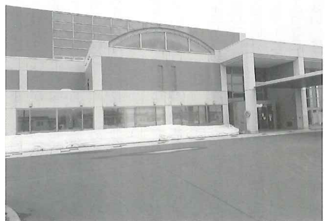
羽幌町総合体育館
