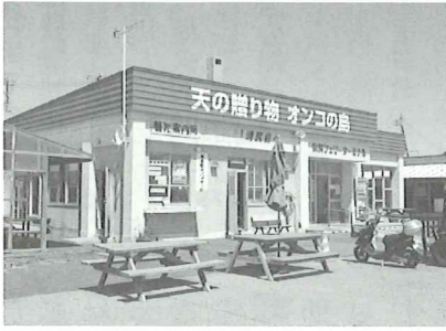
焼尻フェリーターミナル
