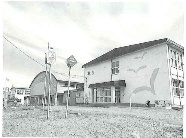
現在の焼尻小中学校の校舎
