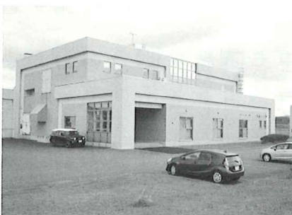
羽幌浄化センター
