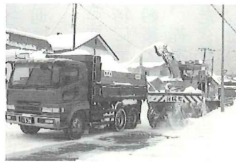
町道の排雪作業
