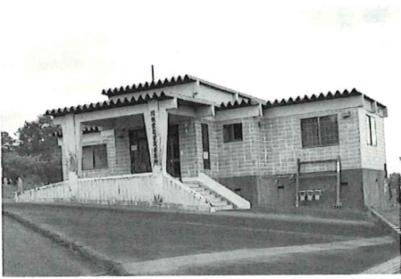
羽幌霊園管理棟
