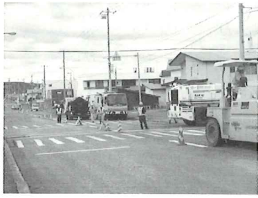
南6条通りの舗装工事業業
