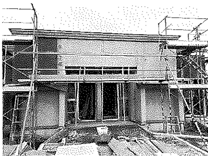
建設中の幸町団地
