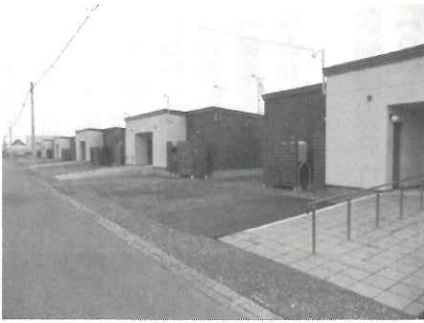
幸町公営住宅
