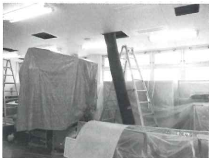
厨房内の仮設ダクト設置
