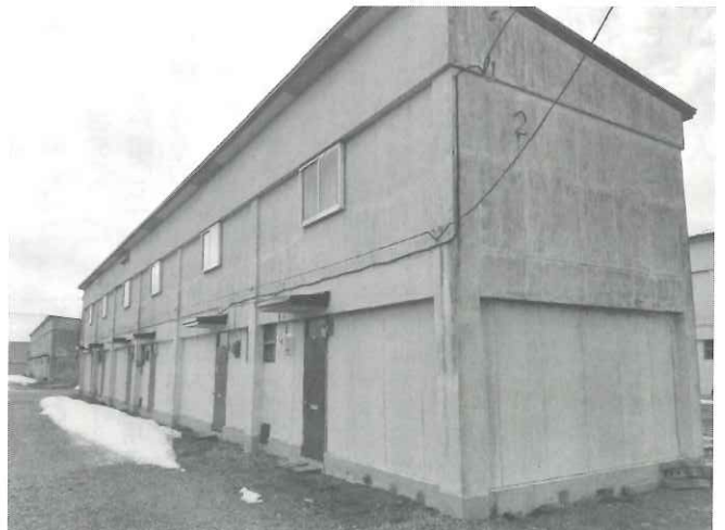
用途廃止となる北町団地2号棟
