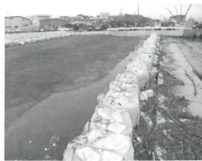
工事中の船揚場(南)斜路
