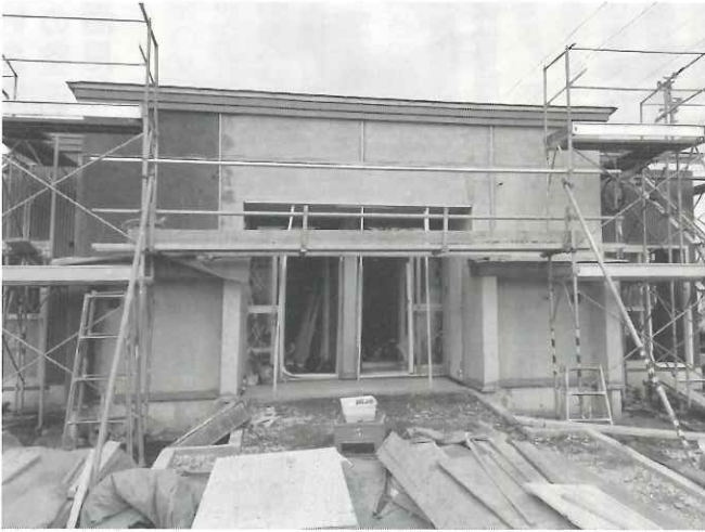
建設工事中の幸町団地（28年度）
