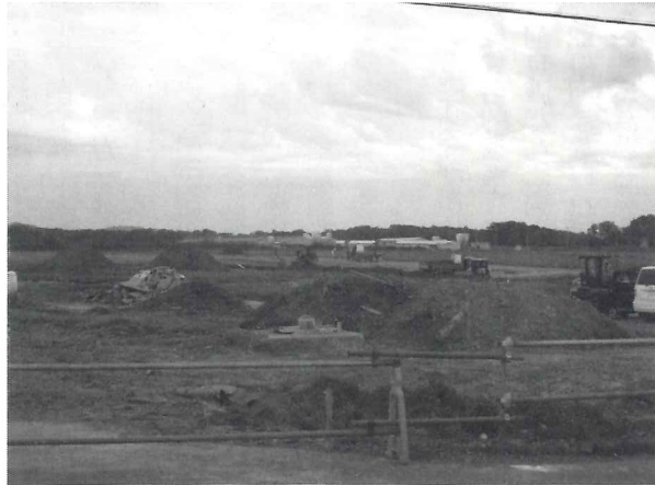
高台で建設が始まった養豚場
