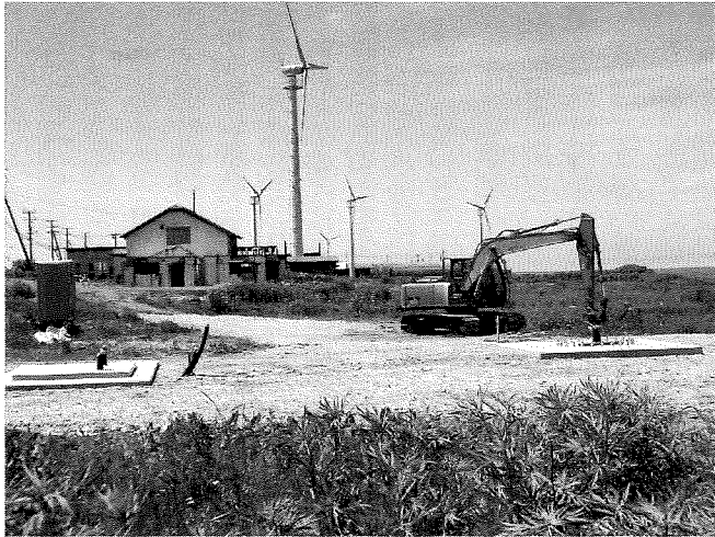
小形風力発電施設設置風景と基礎工事
