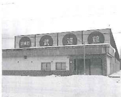
老朽化が進む武道館
