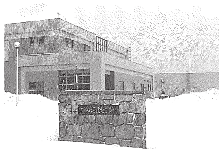
羽幌浄化センター
