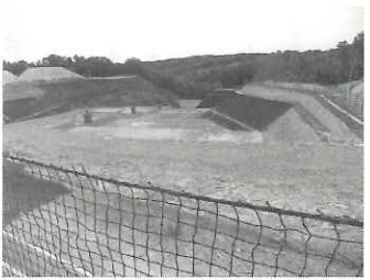
建設中の産廃最終処分場
