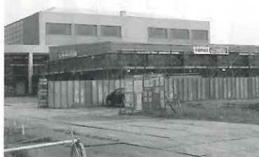
建設中の新武道館
