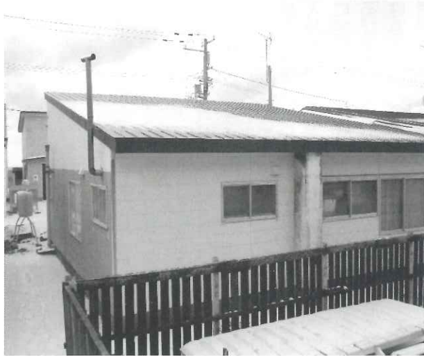
屋根と壁をリフォームした住宅
