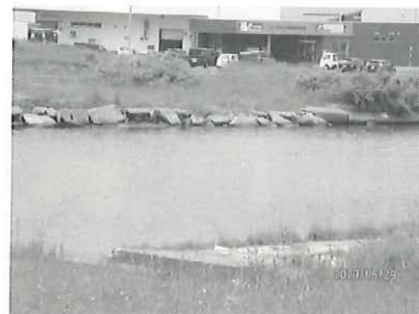
護岸整備工事が始まる福寿川
