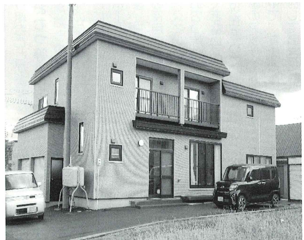
地元業者施工の新築住宅
