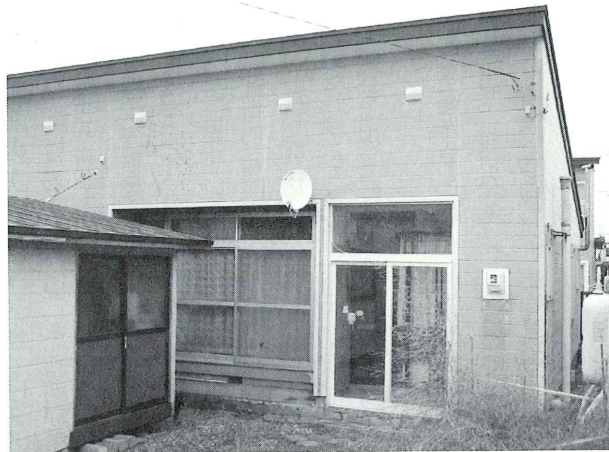
屋根と外壁をリフォームした住宅
