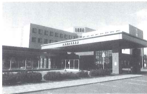
道立羽幌病院
