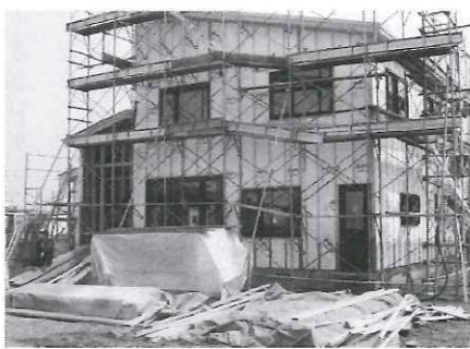
町内の新築工事
