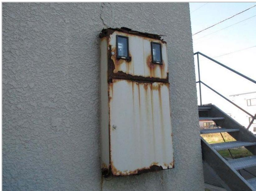
図 2. 2. 3 引込開閉器盤の劣化状況（老人福祉センター）
