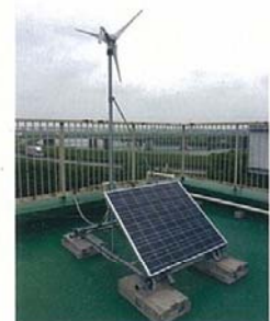
東京都葛飾区立金町小学校 （定格出力 風力 450W+太陽光 150W）
