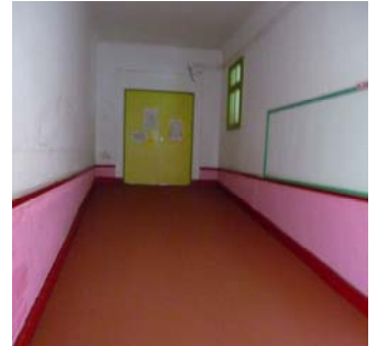
給食センター出入口
