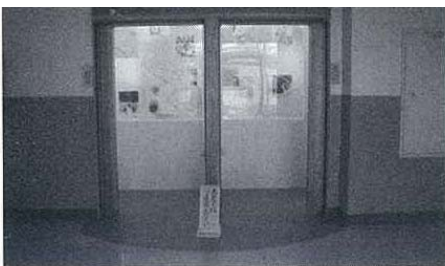
トイレの入口
