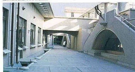
この学校の中を地域住民が通り抜けられるようになっている
