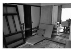
「焼尻地区担当 奥野 真人」 来月、島外から団体を招いて「床張り合宿」を行います。詳しくは次回……。
