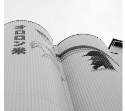
各農家が収穫した米の乾燥処理や貯蔵を行う羽幌ライスターミナル
