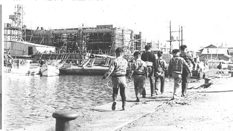
昭和39年 建築中の漁協冷蔵庫
