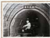
▲坑外輸車路(6トントローローコ)
