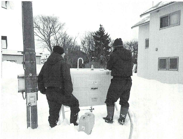
灯油ホームタンクに補充する配達事業者
